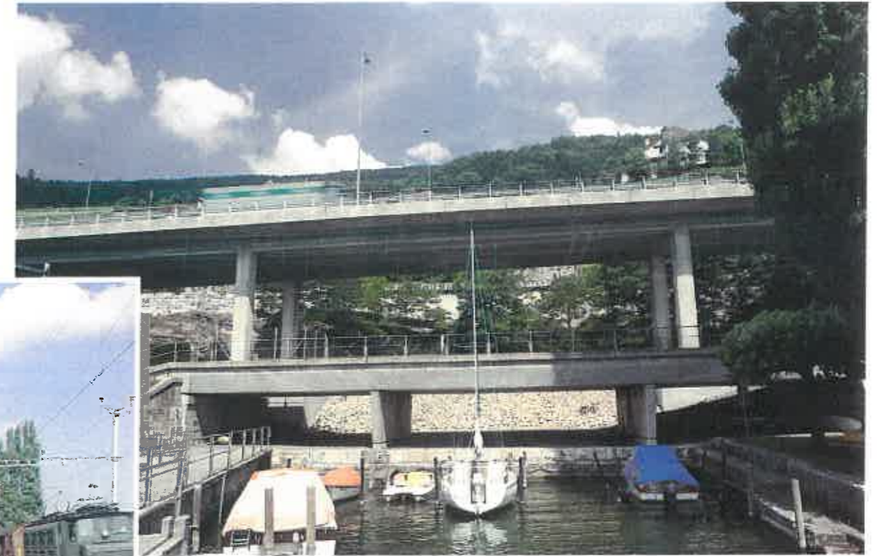
Vom Seeufer aus kann heute in Alfermée der kombinierte Verkehrsstrang Schiene/Nationalstrasse bewundert werden. Wie mag wohl einst der Blick auf die Rebberge gewirkt haben?
