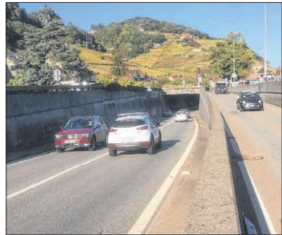
Die A5 verschwindet heute beim Bahnhof Twann in einer Wanne.
